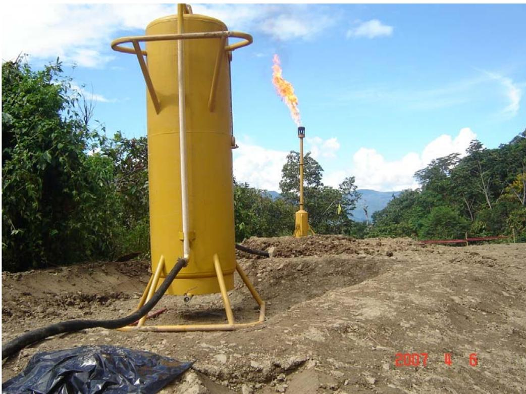
En la foto se observa el TK de choque en donde se separan los líquidos de los gases provenientes de la tubería averiada, los líquidos son almacenados y los gases son quemados en el flare.
